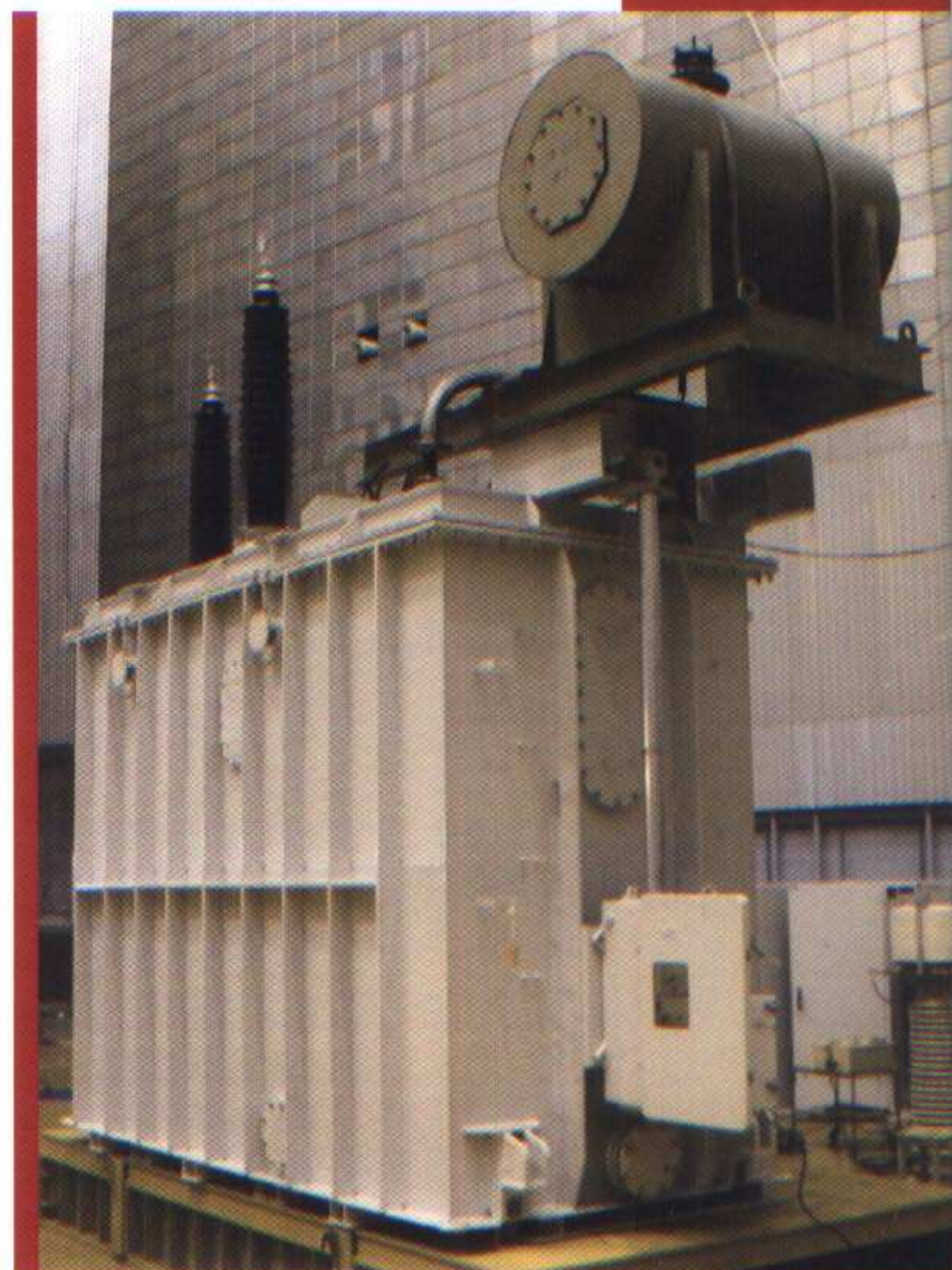
Трансформатор ЭОЦНКР-30000/110 Transformer EOCNKR-30000/110
