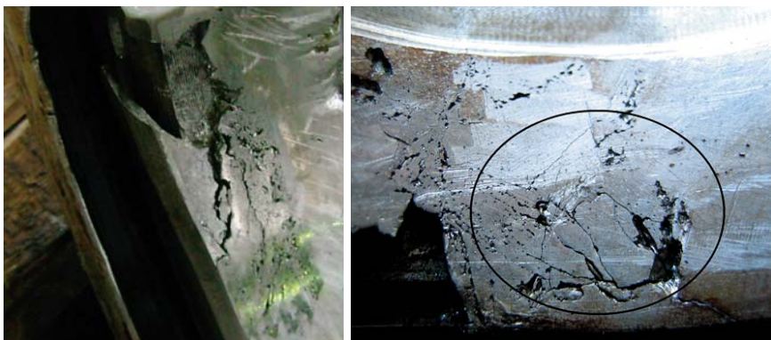
Фото 5. Повреждение баббитовой заливки подшипника в виде хрупкого растрескивания
